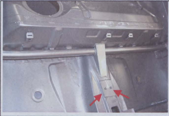
PHOTO N°(01) 7 Fixations centrales des ceintures de sécurité
